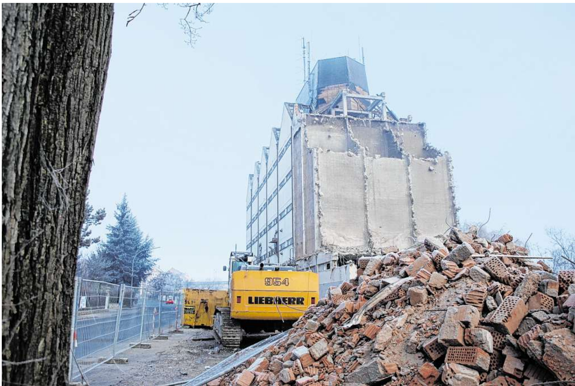
Das ehemalige Baywa-Silo in der Kitzinger Glauberstraße ist schon teilweise abgebrochen. Hier soll ein Wohnhaus mit 31 Eigentumswohnungen entstehen.
