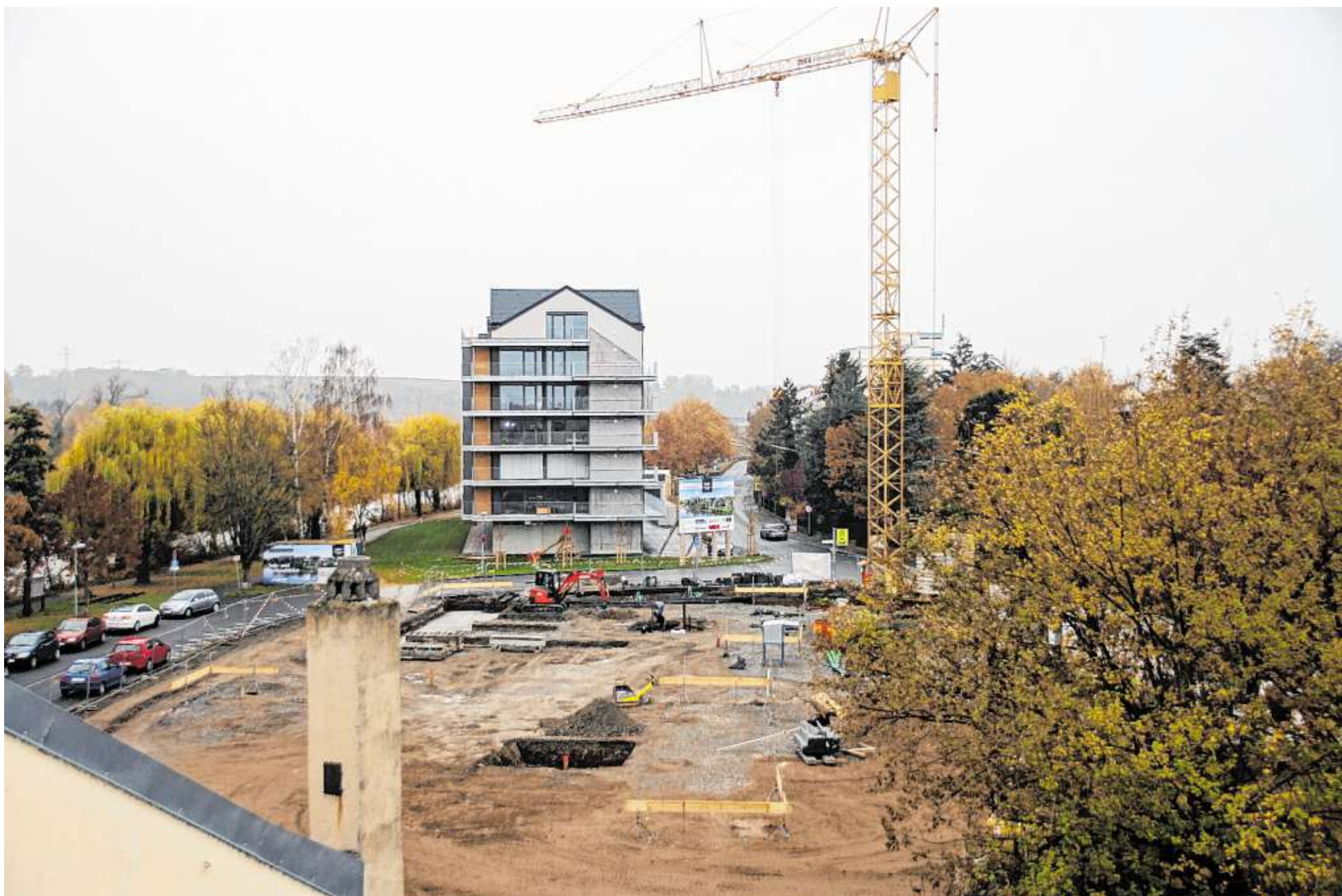
Der zweite Bauabschnitt der Wohnanlage in der Kitzinger Glaubersstraße hat begonnen. Neben den 31 Wohnungen auf dem Gelände des ehemaligen Baywa-Lagerhauses entstehen zwei weitere Wohnblocks mit je sieben Wohnungen.
